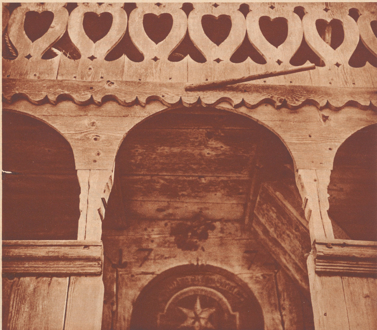
Detail aus der zierlichen, ornamental geschmückten Scheinfassade des Speichers.
