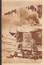
Ist die Lawine nach einem oder mehreren Minemwerfschissen niedergegangen, wobei riesige Schneemassen sich auch auf das Geleise ergossen haben, so tritt sofort die mit Dampf betriebene Schneesshleudermaschine in Funktion, um die Bahn so rach als mögglich wieder frei zu be-
