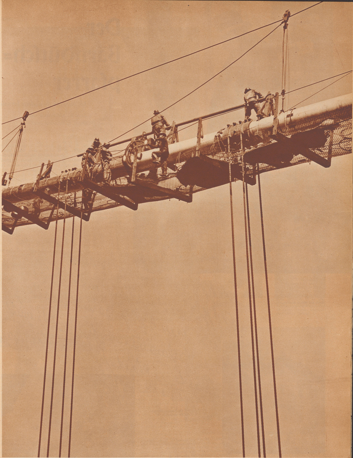
Arbeiter beim «Spinnen» der Tragkabel der San Francisco-Oakland Bay-Brücke. Les ouvriers «tressent» les câbles du pont suspendu San-Francisco-Oakland Bay.
