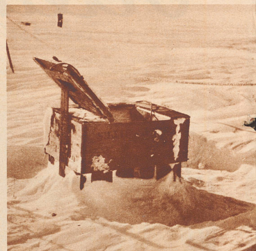
Der Eingang zur Unterisdeckenstation der «Oxford University Arctic Expedition 1935/36» in Nordostland: eine Packkiste mit einer Falltür, die zum Schacht führt, von welchem aus man durch den Haupttunnel das Zelt erreicht.
