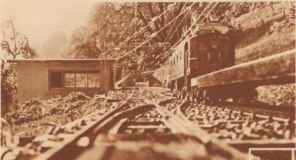
Wenn ihr dieses Bild jemand zeigt und ihn fragt, ob er hier auch schon mit der SBB durchgefahren sei, dann wird er lange überlegen und raten. Er merkt nicht, daß es die Anlage einer Modellbahn im Maßstab 1:10 ist, und daß die Spurweite der Schienen im Vordergrund nur 14,7 cm beträgt.
