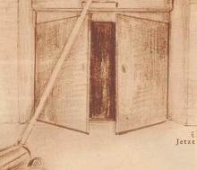
fen, daß ein schräg nach abwärts geneigter Spiegel oberhalb des Garagentores die Sendung des Lichtstrahles vom Scheinwerfer auf die Photozelle vermittelt. Bei dieser Anordnung können Sonnenstrahlen nicht zu der Zelle gelangen, und die Einstellung wird so getroffen, daß das gewöhnliche Tageslicht allein die Wirkung nicht auslöst, sondern dies tritt nur ein, wenn das helle Scheinwerferlicht konzentriert zur Zelle gelangt.
