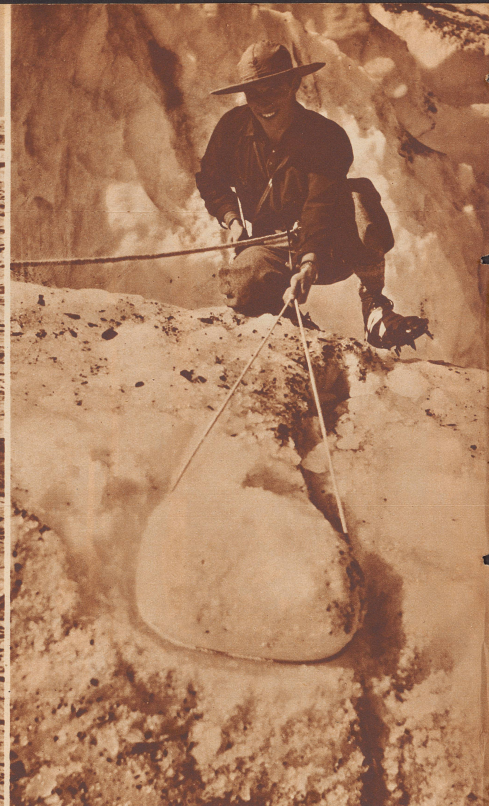
Nicht nur über Felswände, auch über Eiswände wird abgeseilt. Wo sich kein natürlicher Felszacken findet, schafft man sich selbst einen Abseilblock, den man mit dem Piolet aus dem Eis hackt. Um diesen Wulst wird nachher das Seil gelegt, an dem man sich abseilt.
