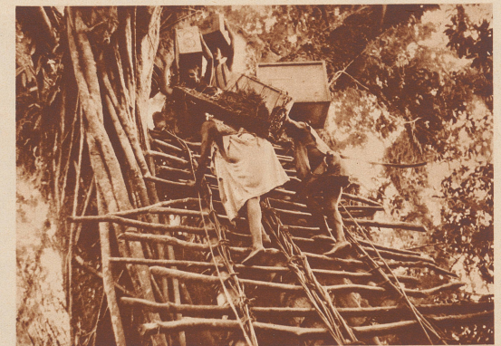
Um sie vor der Überflutung durch die Hochwasser der Regenzeit zu schützen, läßt der Brückenbauer-Urwaldteufel die Hängebrücken fünf Meter über den tiefsten Wasserstand des Flusses schlagen. Steile Leitern führen zum Brückenkopf empor, die den schwerbeladenen Trägern viel Schweiß kosten.
