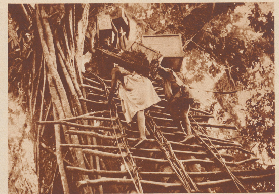
Um sie vor der Ueberflutung durch die Hochwasser der Regenzeit zu schützen, läßt der Brückenbauer-Urwaldteufel die Hängebrücken fünf Meter über den tiefsten Wasserstand des Flusses schlagen. Stille Leitern führen zum Brückenkopf empor, die den schwerbeladenen Trägern viel Schweiß kosten.
