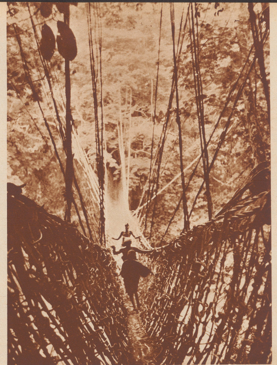
Wie Spinnwebgewebe hängt die Brücke, ganz aus Lianen geflochten, zwischen den Urwaldfußfern. Sie scheint mehr gewachsen als gebaut zu sein, so vollkommen ordnet sie sich dem Pflanzengewirr des Urwaldes ein. Beim Betreten gerät sie in heftige Schwingungen. Sie ist nur für Schwindelfreie gangbar. Durch die dünnen Masten blickt der Fremdling, der darüber geht, auf das Wasser des Flusses hinab und ist froh, daß der Urwaldteufel das Gelände recht hoch flechten ließ.
