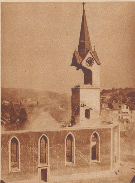
Nachdem die katholische Kirche von Herisau 57 Jahre alt geworden ist, wird sie jetzt niedergelegt, um durch eine größere ersetzt zu werden. Vergangenen 20. Juni nun war für den Turm das letzte Stündchen gekommen. Er wurde gesprengt, und zwar etappenweise, weil der in unmittelbarer Nähe liegende Tunnel der Appenzellerbahn und die nächsten Häuser eine größere Sprengung nicht ratsam erscheinen ließen. Bilder von links nach rechts: Um das Wegschleudern der Steine zu verhindern, wurde der Turm an der Stelle, wo die Sprengladung eingelegt war, mit Tannästen verkleidet. Die erste Ladung war nicht stark genug, um den ganzen Turm zum Einsturz zu bringen, der Helm blieb noch stehen und wurde später mit einem Drahtseil zu Fall gebracht.
