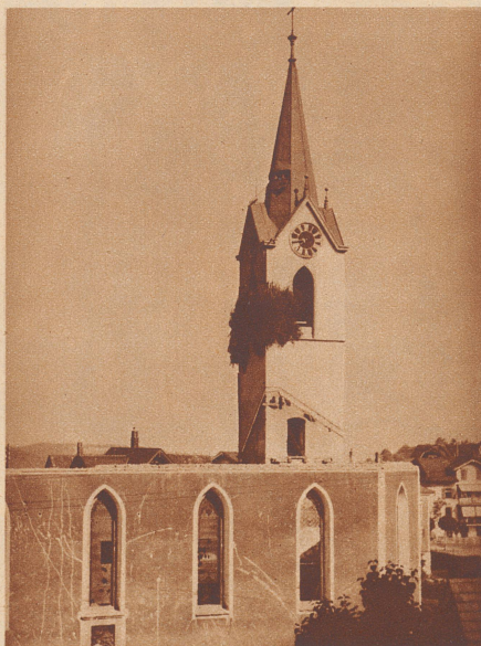
Nachdem die katholische Kirche von Herisau 57 Jahre alt geworden ist, wird sie jetzt niedergelegt, um durch eine größere ersetzt zu werden. Vergangenen 20. Juni nun war für den Turm das letzte Stündchen gekommen. Er wurde gesprengt, und zwar etappenweise, weil der in unmittelbarer Nähe liegende Tunnel der Appenzellerbahn und die nächsten Häuser eine größere Sprengung nicht ratsam erscheinen ließen. Bilder von links nach rechts: Um das Wegschleudern der Steine zu verhindern, wurde der Turm an der Stelle, wo die Sprengladung eingelegt war, mit Tannästen verkleidet. Die erste Ladung war nicht stark genug, um den ganzen Turm zum Einsturz zu bringen, der Helm blieb noch stehen und wurde später mit einem Drahtseil zu Fall gebracht.
