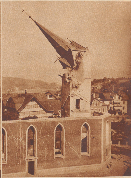
Nachdem die katholische Kirche von Herisau 57 Jahre alt geworden ist, wird sie jetzt niedergelegt, um durch eine größere ersetzt zu werden. Vergangenen 20. Juni nun war für den Turm das letzte Stündchen gekommen. Er wurde gesprengt, und zwar etappenweise, weil der in unmittelbarer Nähe liegende Tunnel der Appenzellerbahn und die nächsten Häuser eine größere Sprengung nicht ratsam erscheinen ließen. Bilder von links nach rechts: Um das Wegschleudern der Steine zu verhindern, wurde der Turm an der Stelle, wo die Sprengladung eingelegt war, mit Tannästen verkleidet. Die erste Ladung war nicht stark genug, um den ganzen Turm zum Einsturz zu bringen, der Helm blieb noch stehen und wurde später mit einem Drahtseil zu Fall gebracht.
