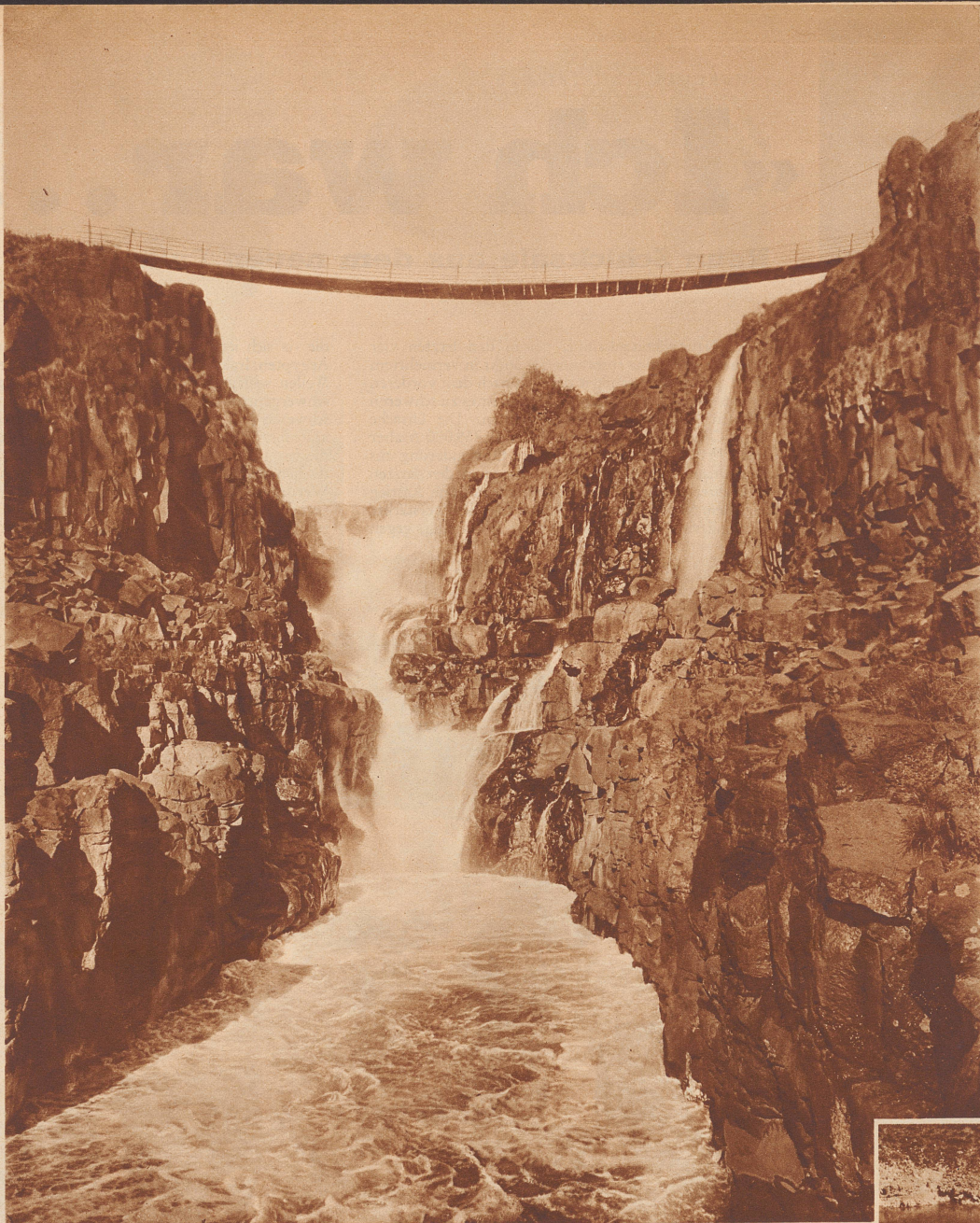
In jahrtausendelanger Arbeit hat das Wasser den Fels so ausgenagt, daß er heute den Anblick von Ruinen bietet. In mehreren größeren und kleineren Fällen stürzt die Wassermasse über die sechzig Meter hohen Wände und fließt in der kaum sechzig Meter breiten Schlucht weiter. Rund 30 000 Kubikmeter Wasser strömen zur Regenzeit in der Sekunde durch diese Rinne. Eine Anzahl Hängebrücken überspannen die Schluchten.
