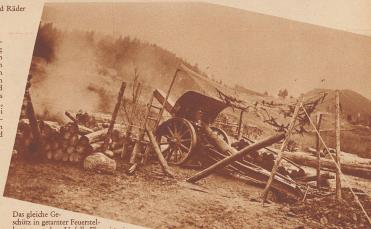
Das gleiche Geschütz in getarnter Feuerstellung vor dem Unfall. Eben ist ein Schuß abgefeuert worden, das Rohr ist auf der Rohrwiege zurückgeglitten um eine Sekunde später wieder in die Schußstellung vorgeschoben zu werden.
