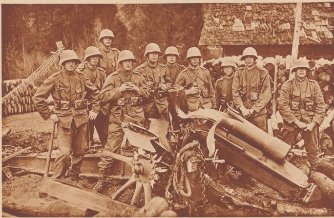
Das eine der zerstörten Geschütze. Rohr, Schutzschild, Verschluß, Schußbremsen, Richtmaschinerie und Räder sind total zertrümmert. Intakt geblieben ist die Lafette und zum Teil die Rohrwiege.
