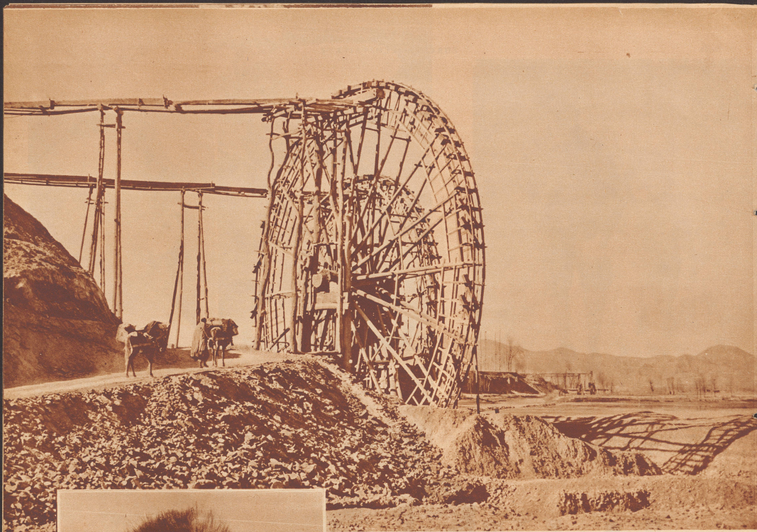
Wasserschöpfrad bei Noriah am Gelben Fluß auf dem Wege nach Sining. Mit solchen kunstvoll gebauten Holzrädern von oft über 10 Meter Durchmesser wird das Wasser zur Berieselung der Reis-, Gerste- und Hirsekulturen aus den Flüssen auf die höher gelegenen Terrassen befördert. Seit uralter Zeit vollzieht sich die Bewässerung in vielen Gegenden Chinas immer noch auf diese primitive Art: mit Menschenkraft wird das Rad angestrichen, in Holzhältern, die an der Peripherie des Rades angebracht sind, wird das Wasser in Flüsse gefaßt, durch Drehung des Rades 10 Meter in die Höhe gehoben, dort durch einen Holzkanal in ein Bassin entleert und von hier zu den Pflanzungen geleitet.
