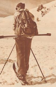
Ein Ausrüstungsgerät nur für Gebirgstruppen und nur für den Winterdienst: die Sondierstange. Sie dient dazu, um im Falle von Verschüttungen durch Lavinen sofort die Suche nach Verunglückten aufnehmen zu können. Die Sondierstange besteht aus mehreren Teilen, die bis zu einer Länge von vier Meter zusammengeschraubt werden können.
