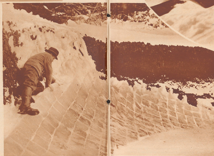
Kurvenmauerung mit Eisziegeln an der Olympiabobbahn in Garmisch-Partenkirchen.
