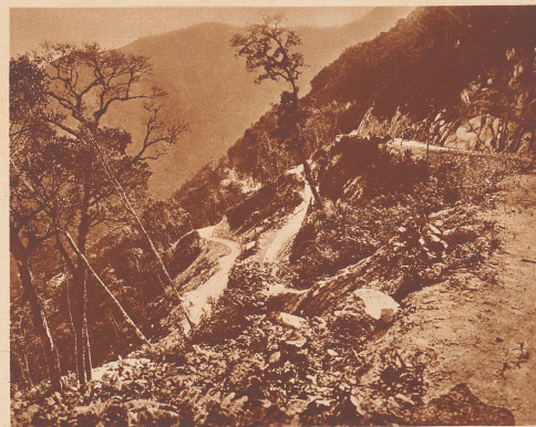
Betonierte Automobilstraße von Maracay über die Küstenkordillere (im Bau). Im Mittelgrund links die alte, rechts die neue Straßenführung. Unser Berichterstatter befuhr sie 1932 während des Baues. — Die Höhen des Gebirgstranges deckt dichter, tropischer Urwald. Links in der Tiefe ist eine Kakao-Farm sichtbar. Der Theobroma (Kakao)-Baum wächst hier nicht in geschlossenen Pflanzungen, sondern, wie übrigens auch der Kaffeestrauch, in halbschattigen Wald-Beständen.
