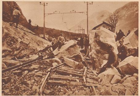
Durch Blöcke von vielen Tonnen Gewicht wurden die Schienen wie Zündhölzer zerbrochen, verbogen und verschoben. Viele dieser riesigen Blöcke mußten durch Sprengung und mit Kranen entfernt werden.
