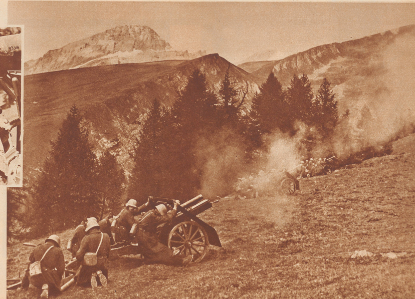
Der Richtier am Aufsatzfernrohr. Seine Arbeit erfordert größte Genauigkeit und Zuverlässigkeit. Das Schießen der Gebirgsartillerie erfolgt fast ausschließlich auf indirektem Wege. Das Aufsatzfernrohr ermöglicht es, auf dem Wege über ein beliebig gelegenes Hilfsziel das Geschützrohr auf ein unsichtbares Ziel zu richten.
