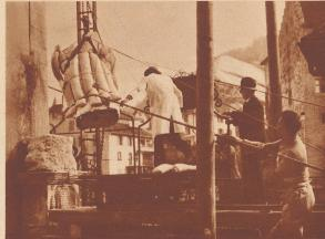
Vollständig eingegipst und gut gepolstert wird die 1½ Tonnen schwere Figur mit einem Flaschen-zug von dem alten Standort gehoben und mit einem Rollwagen ins Museum transportiert.
