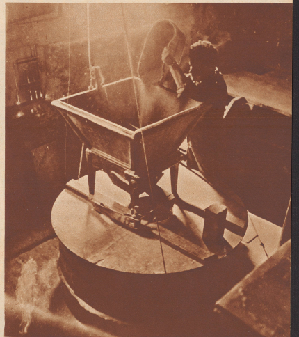
Im Innern der Mühle im oberen Stock, dort wo das Korn eingeschüttet wird. Es geht ohne Dynamo und ohne Transmissionen, ja fast ohne Eisen. Da meinet in Stein und Eisenholz. Draußen pumpt das Wasser über große Lauf. Ja, die Zahne des 80 Zentner schweren Wellenbaums sind aus Holz geblieben. Kein Ölstrophen, keine Purzwelle, ein bodenständige Werk in tiefstem Sinne des Wortes.
