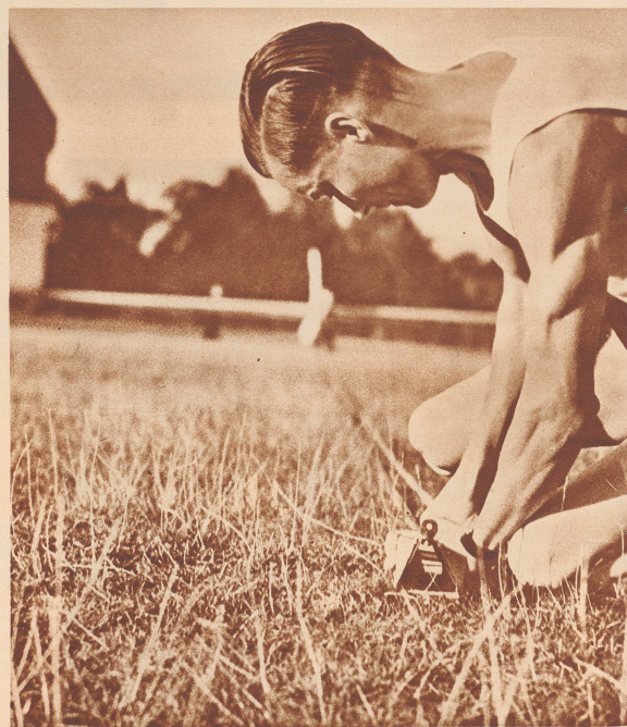
Zum Zwecke des Startes werden zwei Anker in die Erde geschlagen; der eine, an dem das Flugzeug bis zum Start festgehalten wird, der andere 60 Meter davon entfernt. Dorthin spannt der Pilot das Gummikabel, durch des
