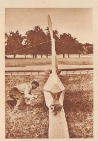
Räder besitzt das Muskelkraftzeug nicht, es startet mit einer Kufe auf einer geseiften Gleitbahn und landet wie ein Segefflug-zeug. Das Bild zeigt einen der Konstrukteure, Haessler, beim Einschlagen des Hakens, der die Maschine bis zum Start festhält.
