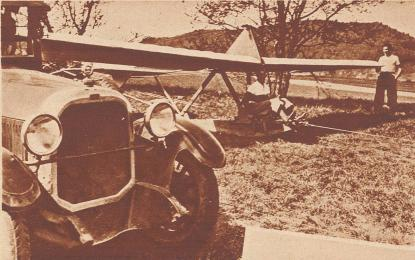
Das Auto steht neben dem startbereiten Segelflugzeug. Der Motor wird in Gang gesetzt, und ein Kommandeur am Flugtisch wird eingehängt, und die Trommel setzt sich in Bewegung, das Seil zieht an. Der «Zöglings» rutscht dann etwas schneller, nun muß der Flugschüler mit der Verwindung die vordere Ruderzelle so lange festhalten, bis der Fluglehrer Gas geben im Gleichgewicht halten. Der Fluglehrer gibt Gas, dann noch ein schnelles, leichtes Ziehen am Höhensteuer: die Maschine hebt ab.
