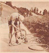
Der Ersatzreifen am Ort. Es gibt Fahrer, die ihn nach alter Weise mit einer Handpumpe aufpumpen, andere haben einen kleinen Tubus mit komprimierter Luft, eine Art Stahlflasche im Kleinen, bei sich, den setzen sie an und mit Sekundenschnelle ist der Reifen prall gefüllt. So ein Tubus mit komprimierter Luft reicht für 4–5 Reifen.
