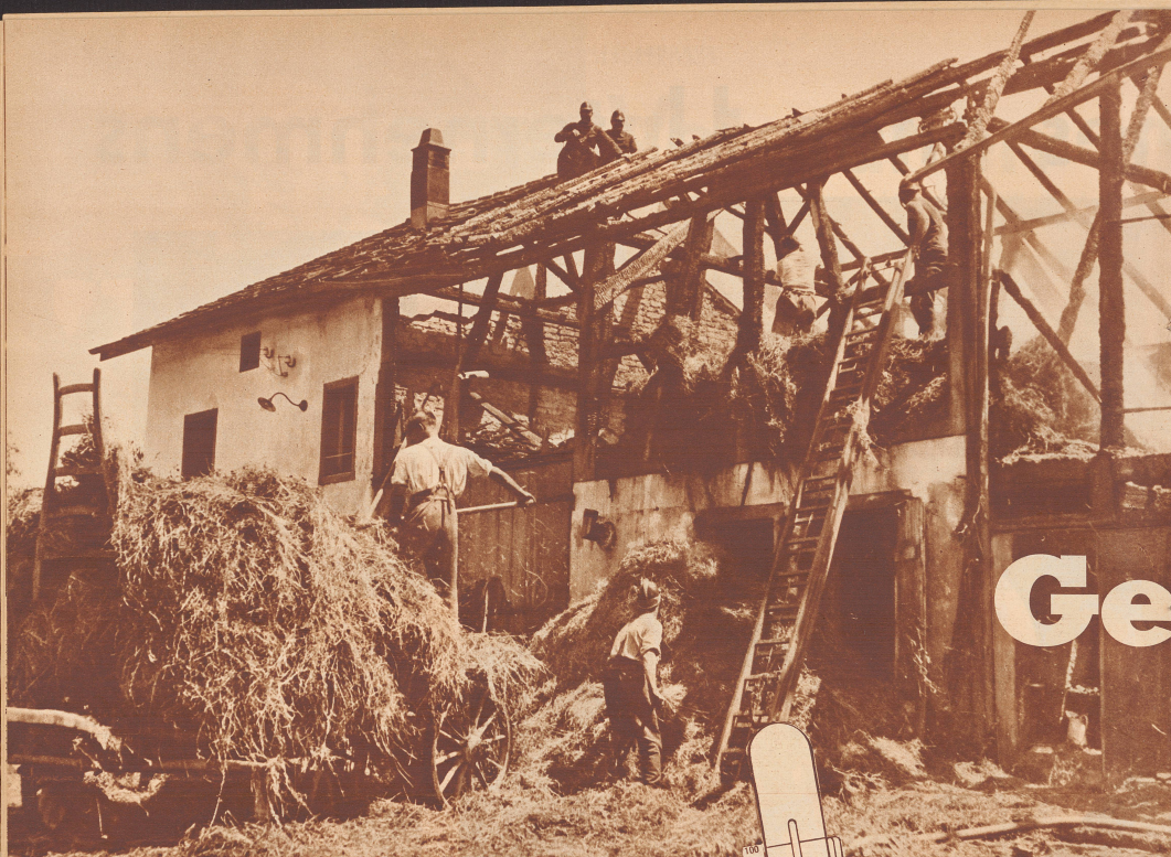
Ein Beispiel von vielen: Der Brandfall durch Selbstentzündung des Heustockes am 8. Juli 1935 in Wetzikon (Zürich). Der Brand im großen ist gelöscht. Die Feuerwehr ist daran, den in Brand geratenen Heustock vorsichtig und unter Anleitung des fachmännischen Experten abzutragen, um die Brandursache festzustellen. Das vom Stock herabgeworfene Heu ist natürlich ganz durchdräht. Es wird auf Wagen fortgefahren und in den umliegenden Wiesen zum Trocknen ausgebreitet. Es ist nur noch als Streu verwendbar.
