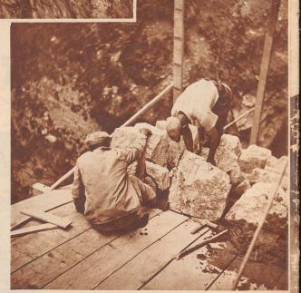
In schwindelnder Höhe arbeiten die Maurer. Stein an Stein wird zu-rechtgerückt, bis jeder genau seinen Platz gefunden hat. Die schmalen Lücken werden mit Mörtel verbunden, damit keiner der steinernen Keile herausfällt, wenn die Bretterunterlage abgebrochen wird.
