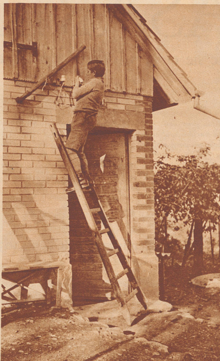
Am Hühnerstall selbst werden die Drähte nochmals um die Isolierzapfen gewickelt.
