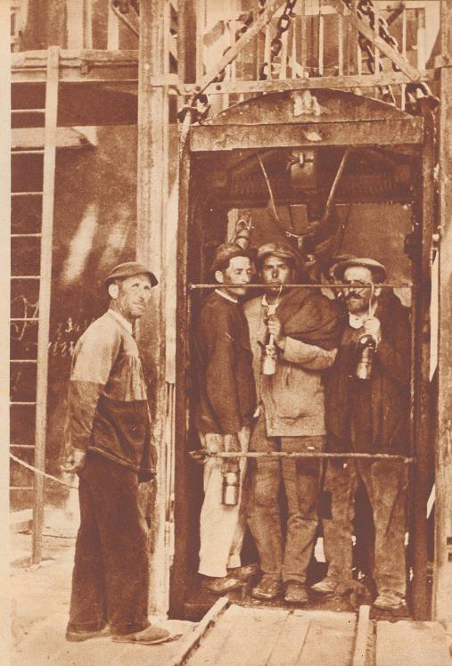
Einfahrt in den Schacht San Aquino. In fünf Minuten Fahrt hält der Förderkorb 370 Meter unter der Erde. So tief ist man bis jetzt in Almadén in die Tiefe gedrungen. Noch immer, wie vor 500 Jahren, ist die Ergiebigkeit dieselbe. Zuweilen werden Blöcke gefördert, die 35 % Quecksilber enthalten.
