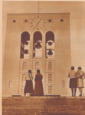
Im Kirchturm der Paulskirche sind die Glocken nicht von Steinmauern eingeschlossen, sondern sie hängen an Glockenbalken, harmonisch angeordnet, für jeden sichtbar.
