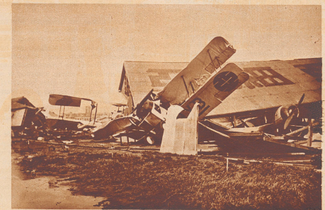
Eingestürzter Hangar der «Asiatischen Fliegerschule» Susaki bei Tokio. Durch den Einsturz wurden 10 Apparate zum Teil schwer beschädigt, zum Teil gänzlich zerrümmert.
