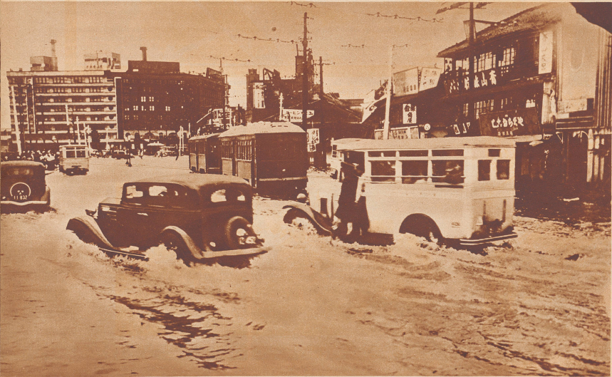
Während mehreren Stunden waren die Straßen von Osaka meterhoch überflutet.
