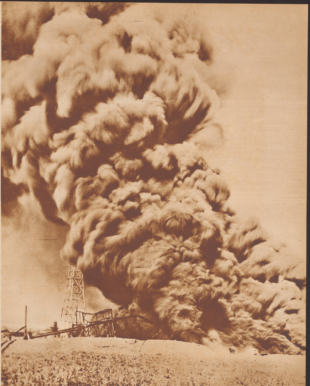
Diesmal nicht in Amerika. Im kürzlich entdeckten Erdölgebiet von Nienhagen bei Hannover (Deutschland) entstand in der Bohrung «Nienhagen 22» eine Gasexplosion, die einen schweren Brand zur Folge hatte. Der Bohrturm stürzte ein und tötete vier Arbeiter. Zwölf andere wurden schwer verletzt.
