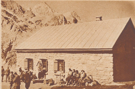
Die Forno-Hütte der S. A. C.-Sektion Rorschach. Diese neue Hütte, erreichbar von der Bahnstation St. Moritz oder der Poststation Maloja, wurde Sonntag den 30. September, eingeweiht. Sie steht auf 2570 Meter Höhe, im schönsten Tourengebiet des Bergell. Sie ist ein massiver Steinbau und enthält 48 Schlafplätze. Die Baukosten belaufen sich auf 32 000 Franken.
