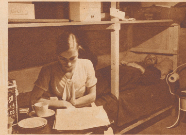
Der Luftschutzraum. Zweck des Luftschutzraumes wird sein, sowohl vor Bombenpausen als auch vor Bombensplittern Schutz zu bieten. Unser Bild gibt einen guten Überblick, wie ein solcher Luftschutzraum einzurichten ist. Er enthält Lagerstellen für Kranke, Proviant, Edgeschirr, Notapotheke, Nottoilette und mancherlei andere Utensilien, die für den vielleicht auf Stunden sich ausdehnenden Aufenthalt darin nötig sind.
