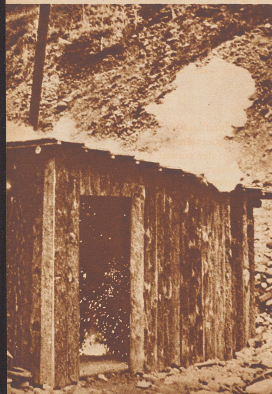
Eine Brandbombe hat in eine zu Versuchszwecken erbaute Baracke eingeschlagen. Durch die offene Tür ist der entstandene Brandherd gut sichtbar. Die Brandbomben dienen dazu, wichtige Gebäude im Feindeland in Brand zu stecken. Sie enthalten als Brandmaterial in der Hauptsache Elektron, einen Stoff, der unter sehr großer Hitze und mächtiger Rauchentwicklung verbrennt und sehr rasch alles entzündet, was in seinem Einflußbereich liegt.
