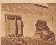
Der Luftschutzraum von außen gesehen. Die äußere Abdichtung der für Luftschutzräume vorgesehenen Keller erfolgt entweder durch starke Auflagen von Sand und Brdsäcken oder durch einen mit Erde gefüllten Holzverschlag.
