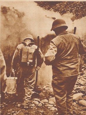
Die Löschmannschaft dringt zum Brandherd vor, um diesen mit Sand zu löschen. Die Bekämpfung von Elektronbrandherden darf niemals mit Wasser erfolgen, da dieses in Verbindung mit Elektron die Feuerbildung nur noch verstärkt. Die Löschmannschaft ist mit dem Sauerstoffgerät ausgerüstet. Der Apparat, ein ähnliches Modell, wie es in der Schweizer Armee eingeführt ist, wiegt 15 bis 20 Kilo und behindert den Mann in keiner Weise bei der Arbeit.
