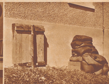
Der Luftschutzraum von außen gesehen. Die äußere Abdeckung der für Luftschutzräume vorgesehenen Keller erfolgt entweder durch starke Auflagen von Sand und Erdschichten oder durch einen mit Erde gefüllten Holzverschlag.
