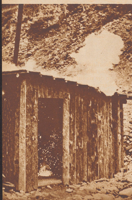
Eine Brandbombe hat in eine zu Versuchszwecken erbaute Baracke eingeschlagen. Durch die offene Tür ist der entstandene Brandherd gut sichtbar. Die Brandbomben dienen dazu, wichtige Gebäude im Feindesland in Brand zu stecken. Sie enthalten als Brandmaterial in der Hauptsache Elektron, einen Stoff, der unter sehr großer Hitze und mächtiger Rauchentwicklung verbrennt und sehr rasch alles entzündet, was in seinem Einflußbereich liegt.
