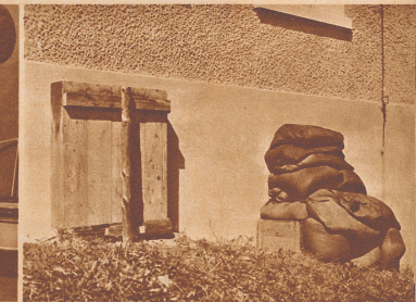
Der Luftschutzraum von außen gesehen. Die äußere Abdeckung der für Luftschutzräume vorgesehenen Keller erfolgt entweder durch starke Auflagen von Sand und Erdschichten oder durch einen mit Erde gefüllten Holzverschlag.
