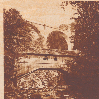
Wie ein Symbol vom Wandel der Zeiten sind diese zwei Brücken über die Lorze: Die alte Holzbrücke schließt die Wehwasserbecken und den Riegelbauten im Hintergrund. Die neue, steinerne und ebenerdig, der Beton-Viadukt kühn und elegant.
