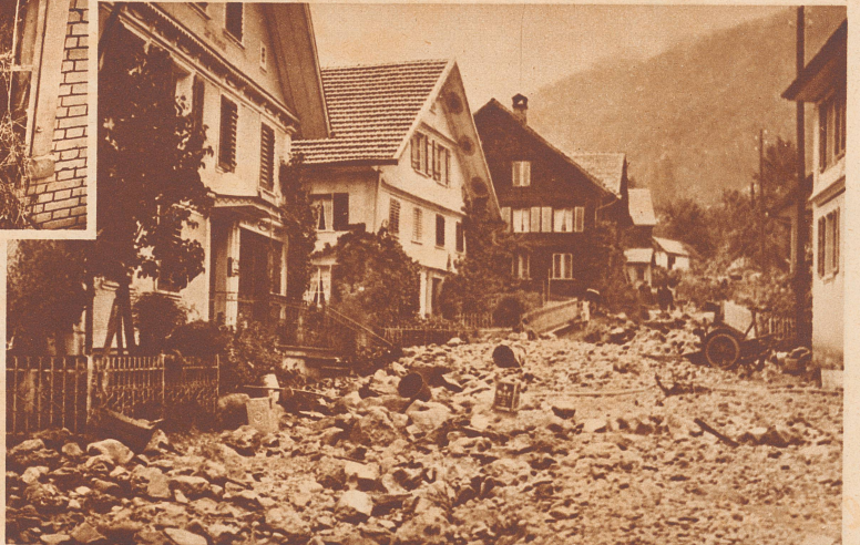
Von der Innerschweiz pflanzte sich das Unwetter nach Nordosten fort und hat besonders am oberen Zürichsee und im Gasterland schlimme Spuren hinterlassen. Bild: Die Hauptstraße des Dorfes Maseltrangen am Morgen nach der Katastrophennacht. Zentnerschwere Blöcke sind vom Speer herab in die Straßen und Gärten geschwemmt worden. Aufnahme Ensslin
