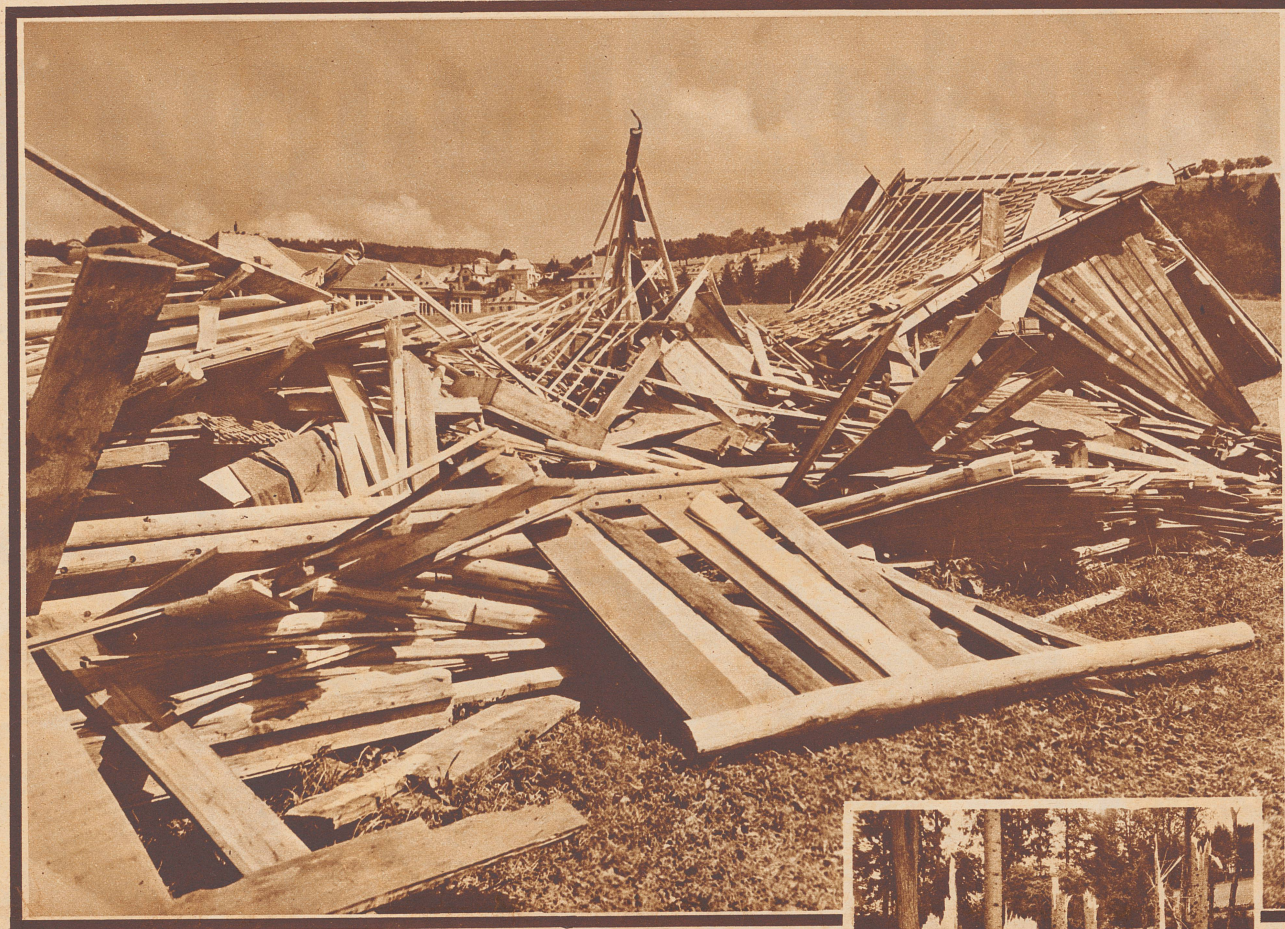
An der Straße von Le Locle nach Col-des-Roches wurde ein Magazin durch den Orkan vollständig zerstört. Innert einer halben Minute war das Gebäude umgelegt. Ein Bauarbeiter wurde durch den Einsturz schwer verletzt.
