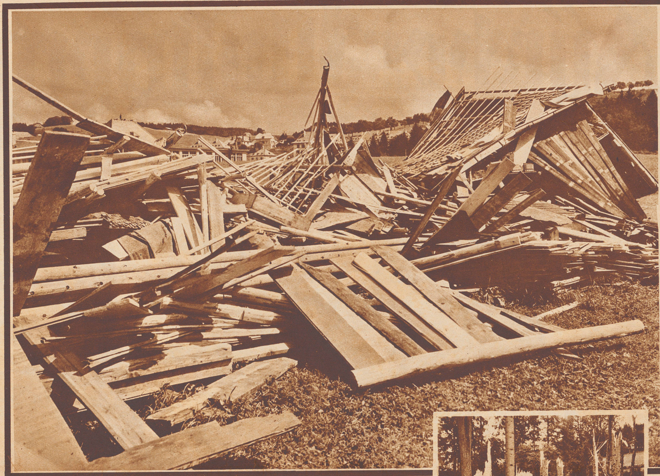
An der Straße von Le Locle nach Col-des-Roches wurde ein Magazin durch den Orkan vollständig zerstört. Inert einer halben Minute war das Gebäude umgelegt. Ein Bauarbeiter wurde durch den Einsturz schwer verletzt.
