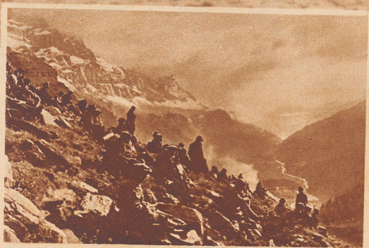
Zuschauer beim Klausenrennen auf der Paßhöhe. Blick auf den Urnerboden.
