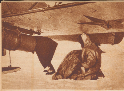
Die Rettung der «Tscheljuskin»-Leute durch die Flieger. Das ist der Apparat Molokows. Viermal flog er von Kap Wankarem auf die treibende Scholle. Obwohl die Maschine nur für zwei Passagiere berechnet ist, brachte er mit jedem Flug fünf Leute aufs Festland. Dies gelang ihm dadurch, daß er in der engen Kabine fünf Leute unterbrachte und zwei weitere unter den untern Tragflächen seines Doppeldeckers festband. Ein Passagier schlüpfte in den Fallschirmkasten, worin er die Reise nach Kap Wankarem absolvierte.
