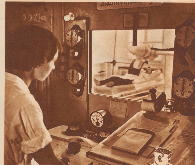
Während der Bestrahlung: Blick aus dem Kontrollraum nach dem Behandlungsraum. Beide Räume sind durch ein Bleiglasfenster getrennt. Blei ist für Röntgen- und Radiumstrahlen praktisch undurchdringlich. Das Bleiglas schützt den Kontrollraum vor unerwünschten Strahlen. Die Wände des Behandlungsraumes bestehen ebenfalls aus strahlendurchdringlichem Baustoff. Die Meßinstrumente müssen während der Bestrahlung genau überwacht werden. Mit diesen Instrumenten wird die Dosis der Bestrahlung bestimmt.
