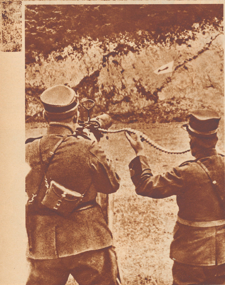
Schießen auf bewegliche Flugzeug-Ziele. Mittels eines Haspels wird die Flugzeugscheibe mit beträchtlicher Geschwindigkeit auf eine Distanz von über 100 Meter vor dem Maschinengewehr vorübergezogen. Der Schießende visiert das Ziel an und feuert, jedoch ohne dem Flugzeuge mit der Visier-Linie, d. h. mit dem Maschinengewehr zu folgen. Gleich die erste Schießübung ergab ein Resultat von 4 Treffern im schwarzen Flugzeuge selbst und 7 Treffer im weißen Teil der Scheibe.
