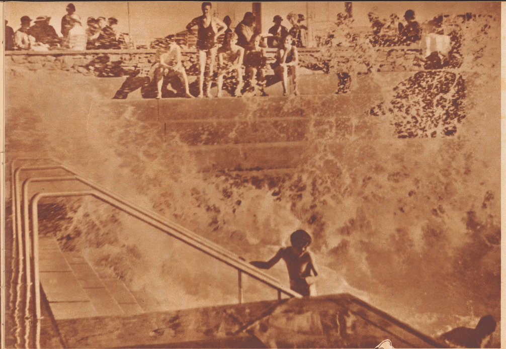
Sturm im Badebassin auf dem Dolder? Nein, der Hebel im Maschinenraum ist auf «Wellenschlag» gedreht und nun brandet die Gischt gegen die gekachelten Mauern.
