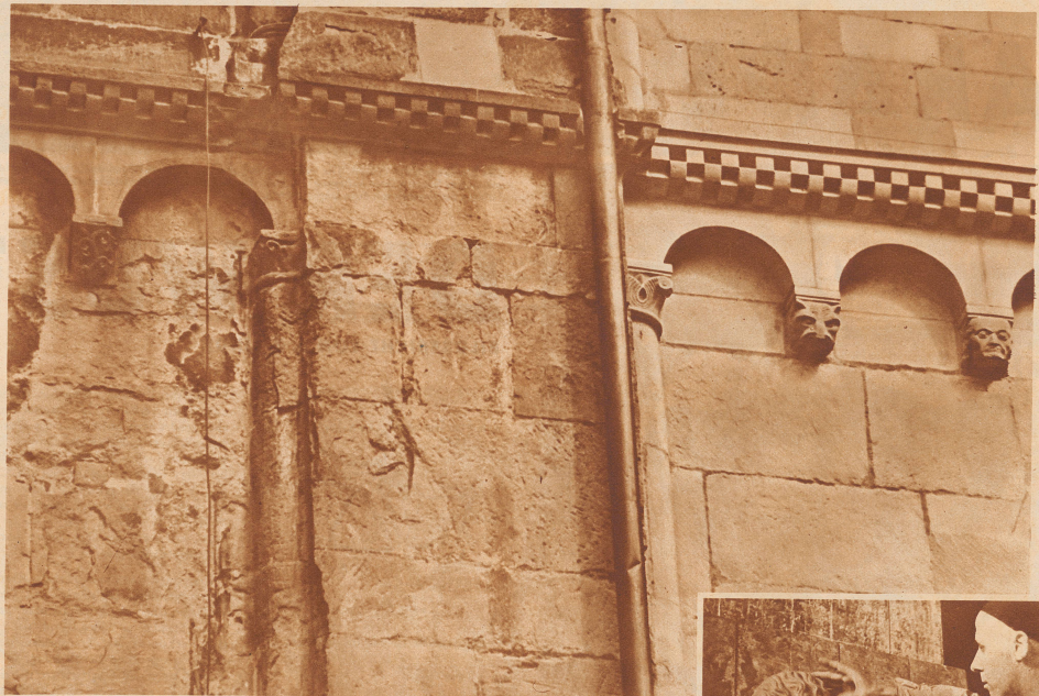
Ein Teil der Mauer ist bereits renoviert, die linke Hälfte wird in den nächsten Tagen in Angriff genommen. Die Konsolen der Bogenfriese tragen in bunter Reihenfolge Tierköpfe, symbolische Zeichen und die in Stein verewigten Gesichter berühmter und verdienter Zürcher aus vergangener und neuerer Zeit.
