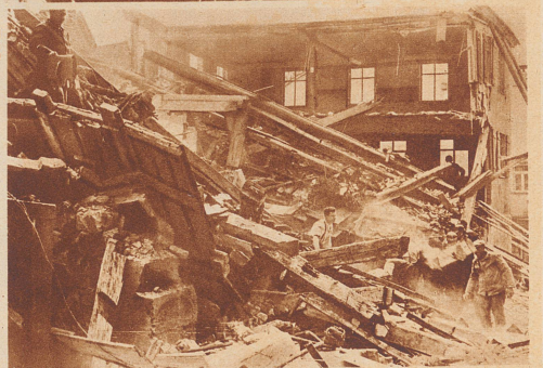
Der eingestürzte Mittelbau des Schulhauses. Aufräumungsarbeiter suchen in den Trümmern nach den vermissten Kindern.
