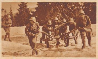
Die Infanteriekanone wird in Stellung gefahren. Das Geschütz wiegt rund 280 kg und läuft auf Gummirädern. Es kann von seiner Bedienungsmannschaft auch in schwierigem Gelände von Hand sehr rasch in Stellung gebracht werden. Für den Einbau in Feldbefestigungen sind die Räder abnehmbar. Als übliche Transportarten sind vorgesehen: Pferdezug mit einem Pferd oder Verladen auf drei Saumtiere.
