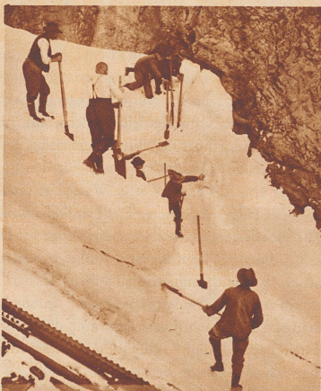
Das in die Rinnen und Ritzen der Felsen eindringende und im Winter gefrierende Wasser lockert das Gestein, und so besteht immer im Frühjahr Steinschlaggefahr. Um die Bahn davor zuverlässig zu schützen, muß ein bergtüchtiger Mann sämtliche das Geleise überragenden Felswände Quadratmeter um Quadratmeter nach lockeren Felsstücken abtasten und die gelösten Teile in die Tiefe befördern.
