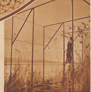
Der Bau einer Fangreus an den Ufern des Sempachersees. Die schilfbewachsenen Gestade dieses kleinen, idyllisch gelegenen Sees sind ein wahres Paradies für Wasser- und Landvögel.
