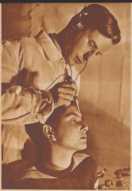
Zunächst wird die Versuchsperson für die Dauer der Untersuchung in den Stromkreis des Apparates eingeschaltet. Der Untersuchungs leiter tastet mit seinem ebenfalls in den Stromkreis eingeschalteten Stift den Kopf des zu Untersuchenden ab. Stößt er auf einer Reaktionspunkt, so ertönt ein Telephonzeichen, und er kann auf dem Meßinstrument die Ausschläge des Zeigers sofort beobachten
