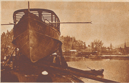
Das Schiff gleitet auf den zwei schiefen Balken, die mit Schmierseife eingefettet sind, seitwärts ins Wasser.
