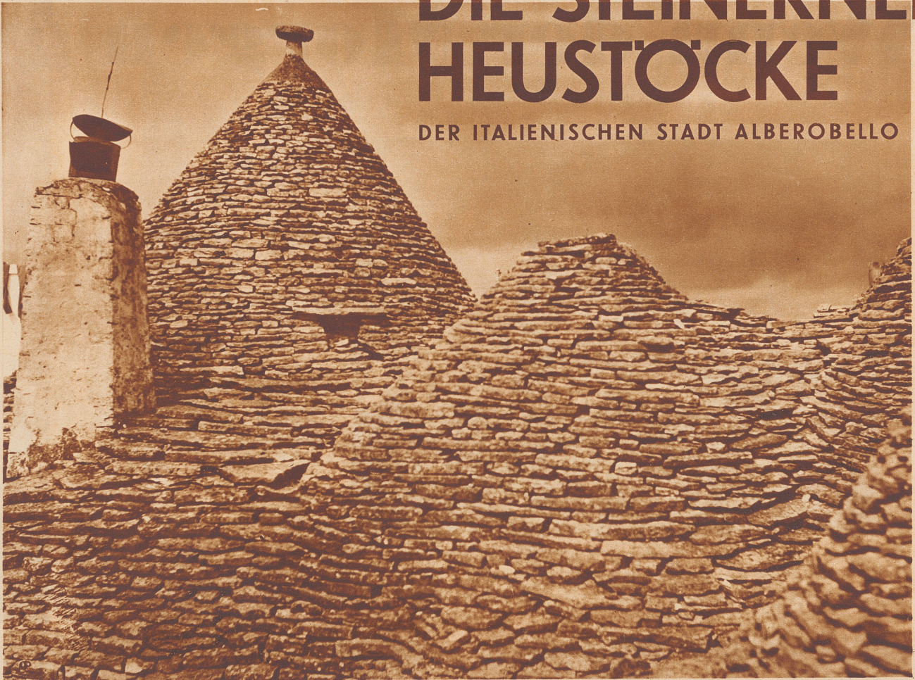
Die kegelförmigen Dächer der Häuser von Alberobello sind sehr sinnreich gebaut. Obschon kein Mörtel verwendet wird, löst sich sehr selten eine der verwendeten Steinplatten los. Die am Dache sichtbare Oeffnung rechts vom Kamin dient als Ventilator.
