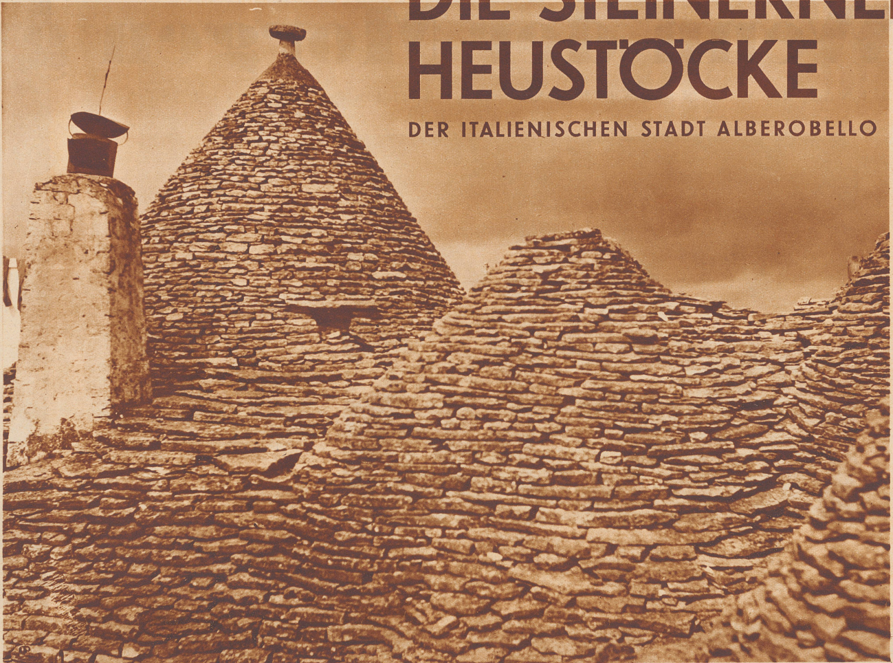
Die kegelförmigen Dächer der Häuser von Alberobello sind sehr sinnreich gebaut. Obschon kein Mörtel verwendet wird, löst sich sehr selten eine der verwendeten Steinplatten los. Die am Dache sichtbare Öffnung rechts vom Kamin dient als Ventilator.
