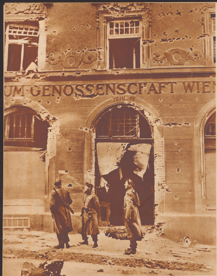
Das zerschossene Gebäude der Konsumgenossenschaft in Ottakring.
