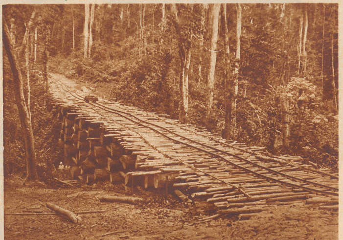
Unebenheiten im Urwaldterrain werden durch Brücken überwunden. Es werden so viele Stämme übereinandergelegt, bis für die Schmalspurbahn ein fast ebenes Trassé erstellt werden kann. Die beiden Menschen auf der Sohle dieser Geländesenkung vermitteln deutlich einen Begriff von der Größe dieser Stämme
