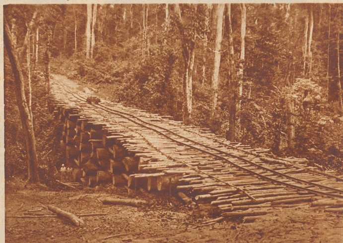
Unebenheiten im Urwaldterrain werden durch Brücken überwunden. Es werden so viele Stämme übereinandergelegt, bis für die Schmalspurbahn ein fast ebenes Tracé erstellt werden kann. Die beiden Menschen auf der Sohle dieser Geländesenkung vermitteln deutlich einen Begriff von der Größe dieser Stämme
