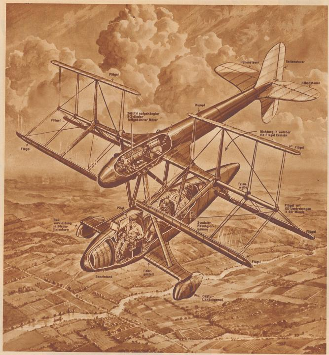
Das Schaufelrad-Flugzeug erhebt sich ohne Anlauf senkrecht in die Luft. Das angewandte System ist leicht verständlich: zwei Flügelgruppen, bestehend aus drei schmalen, miteinander verbundenen Flügeln, werden durch einen 240 PS-Motor zu 420 Umdrehungen pro Minute angetrieben. Wenn diese Schmalflügel kreisen, wird durch eine einfache Betätigung eines Hebek Vorwärtsbewegung, Schwebeflug und sogar Rückwärtsflug ermöglicht.
