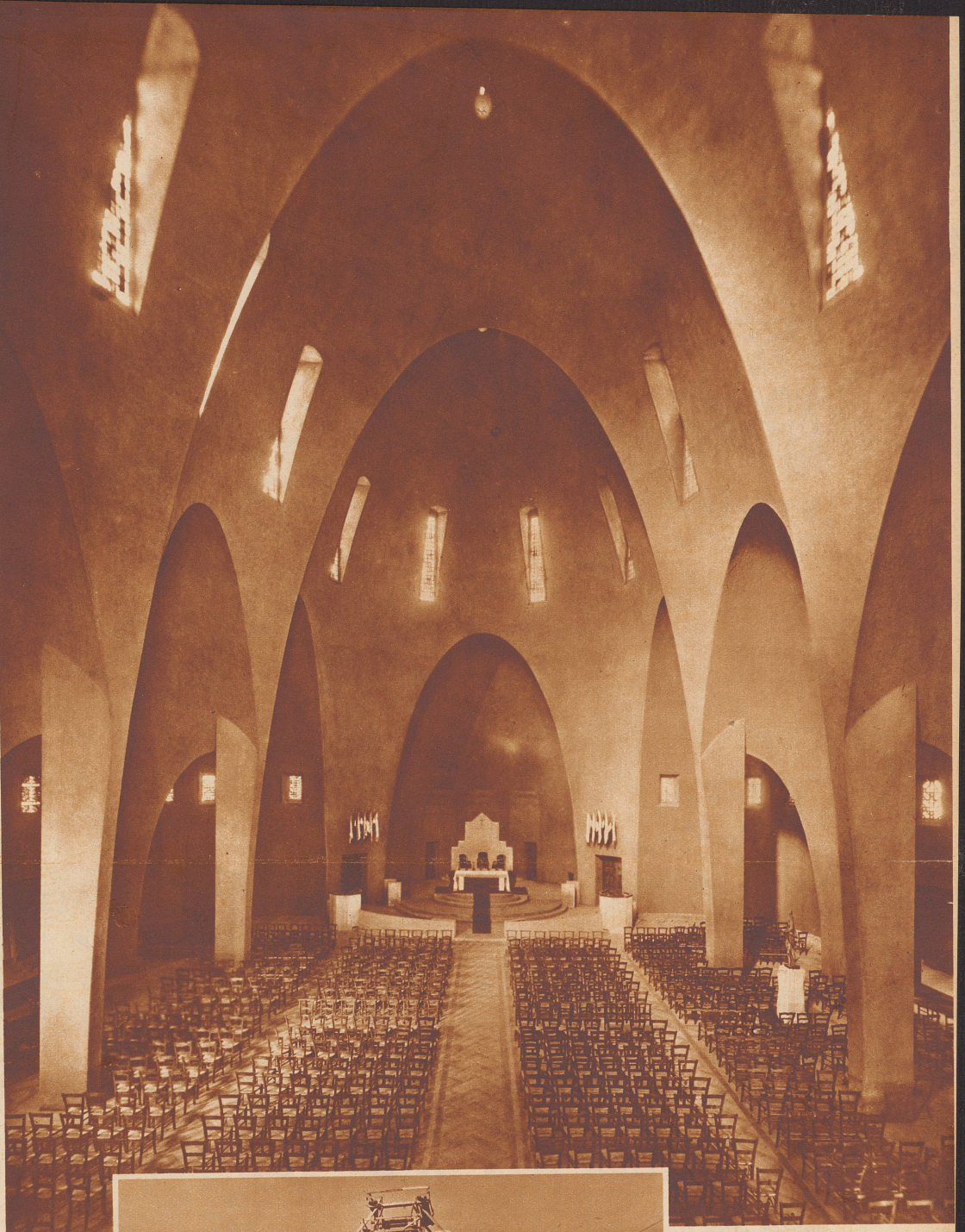
Das Hauptschiff der neuen Kirche «Jeanne d'Arc» in Nizza. Ohne Pfeiler, ohne Säulen, ohne Sandstein oder Granit, ganz aus Eisenbeton!
